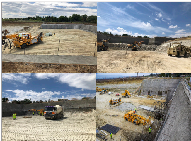
4-7. ábra: A keleti portál bevágás-süllyesztése 2020-ban
